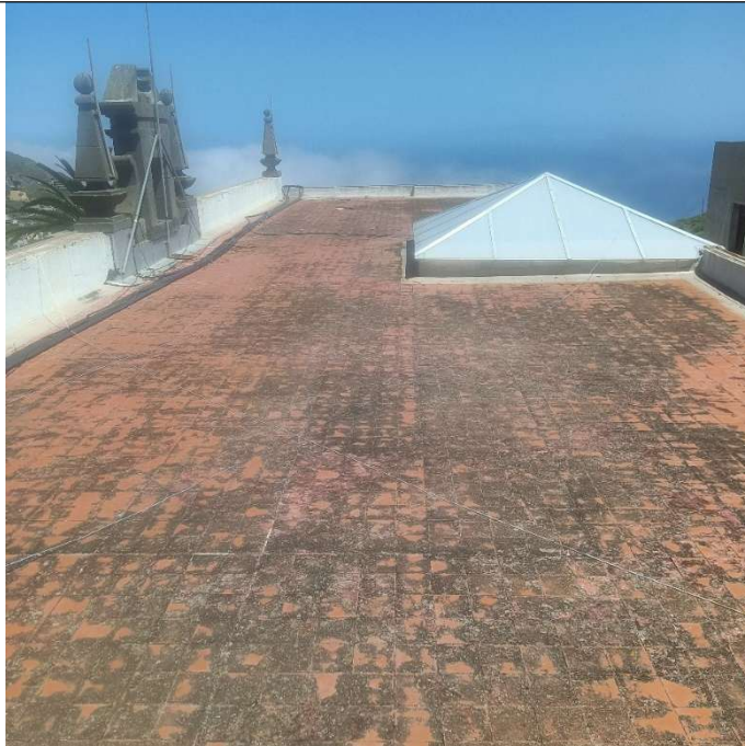
Cubierta Casa Consistorial
