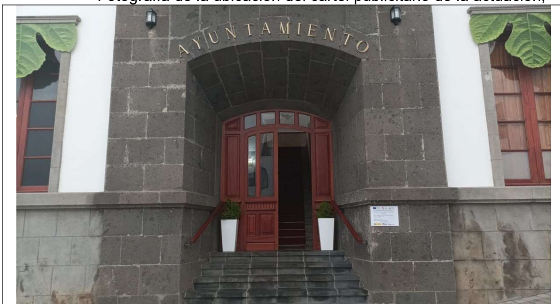
Cartel en fachada del edificio
