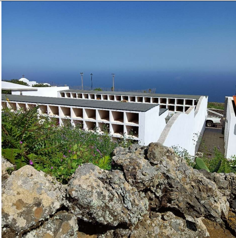
Cubierta Tanatorio El Mocanal
