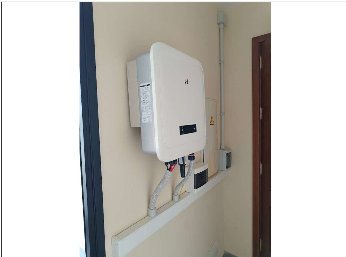
Inversor del Tanatorio de Guarazoca con los cuadros de C.A. y C.C.
