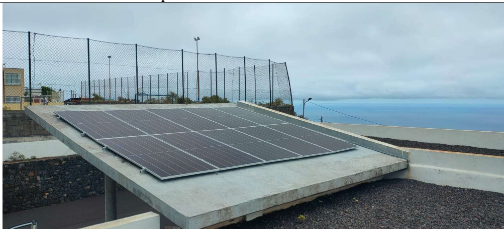
10 paneles colocados sobre cubierta de hormigón inclinada
