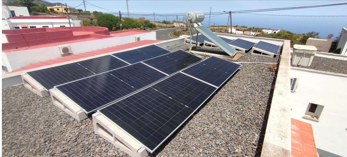
Colocación de 10 Paneles solares de 605 Wp y 17 soportes de hormigón
