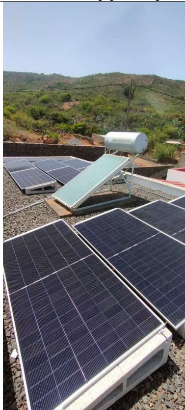
Colocación de 10 Paneles solares de 605 Wp y 17 soportes de hormigón
