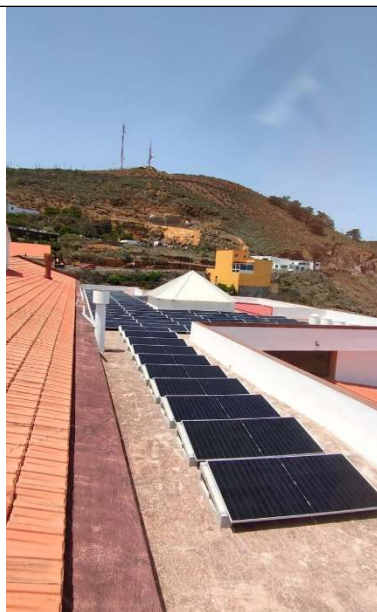
Paneles fotovoltaicos de 605 Wp sobre bloques de hormigón
