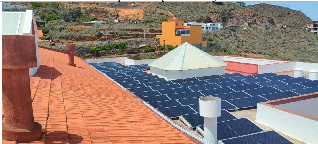
Paneles fotovoltaicos de 605 Wp sobre bloques de hormigón
