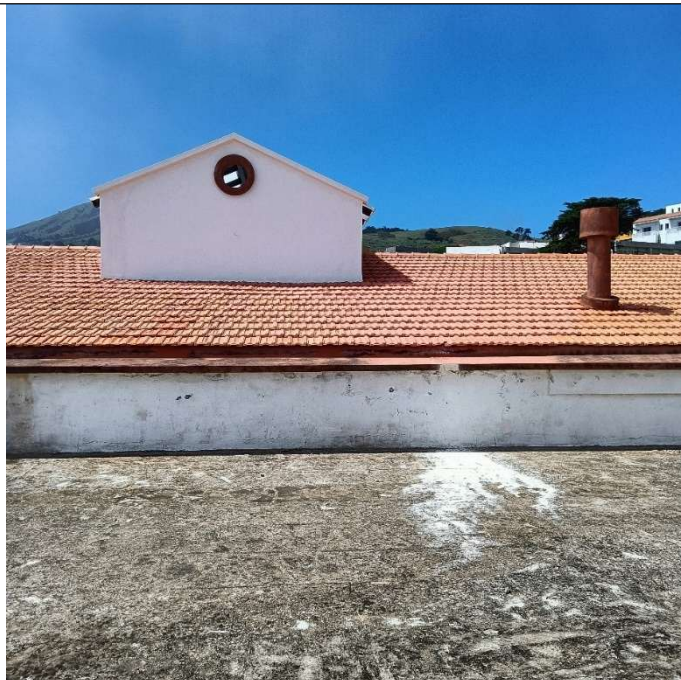
Cubierta Centro Cultural Asabanos, se instalará en la cubierta plana
