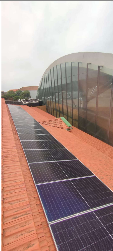
22 paneles instalados de 605 W bifásicos instalados
