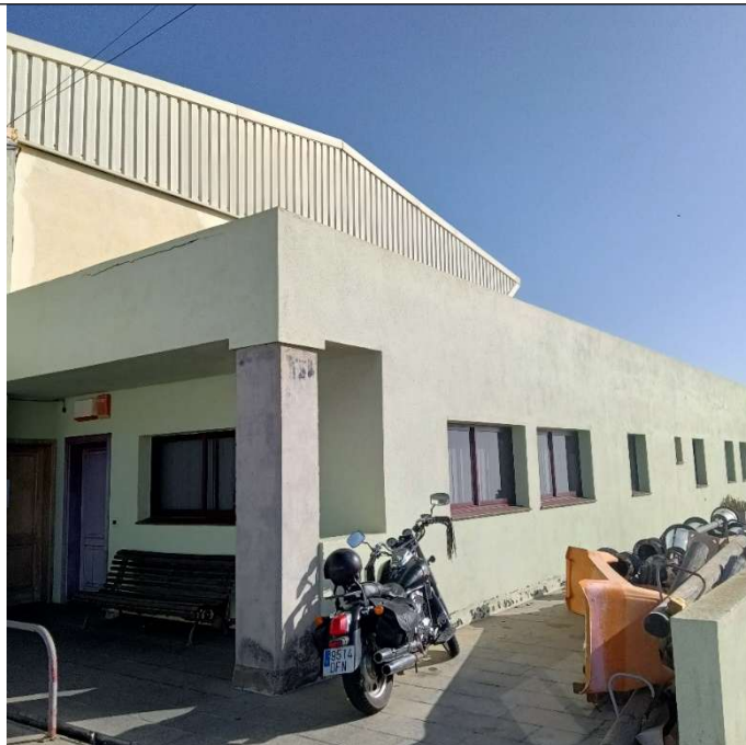
Fachada almacén principal
